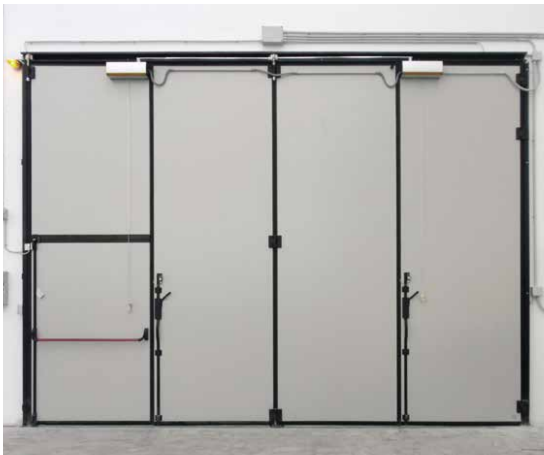
Vista esterna portoni a libro, con lamiera in pvc finto legno tonalità chiara, con porte pedonali e serramenti oblò
